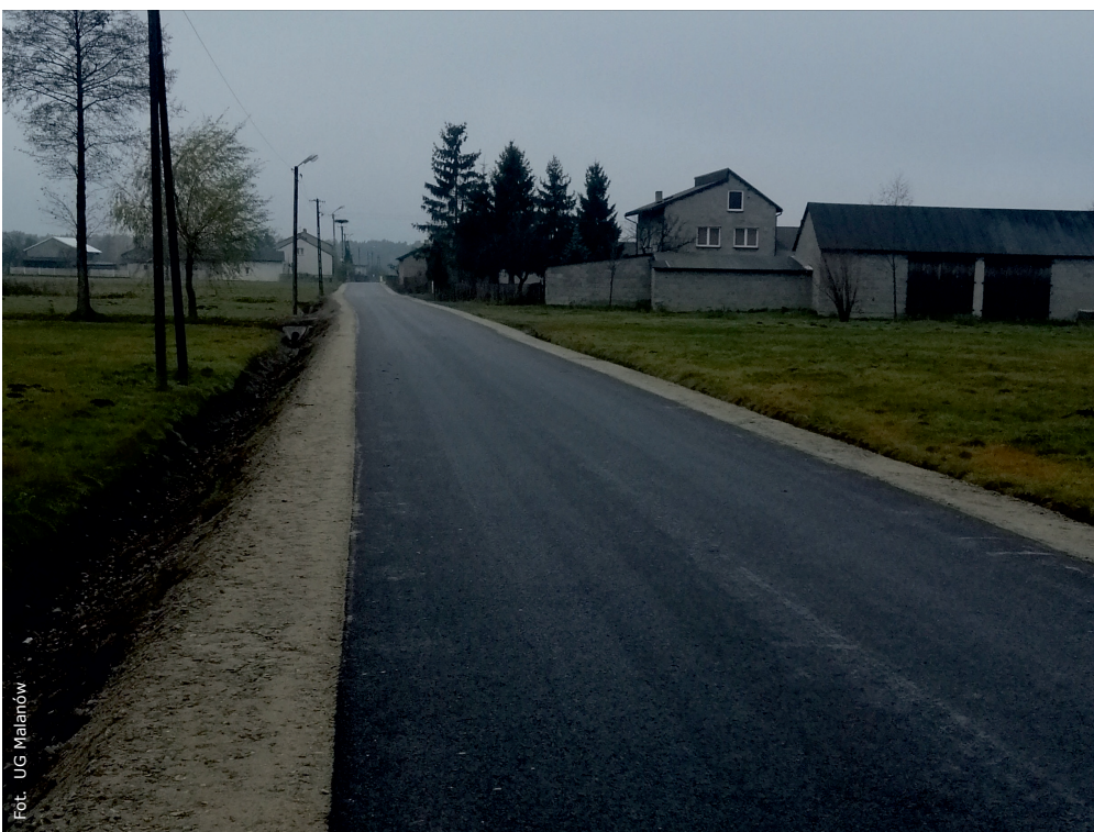
Nowa nawierzchnia drogi w Feliksowie
