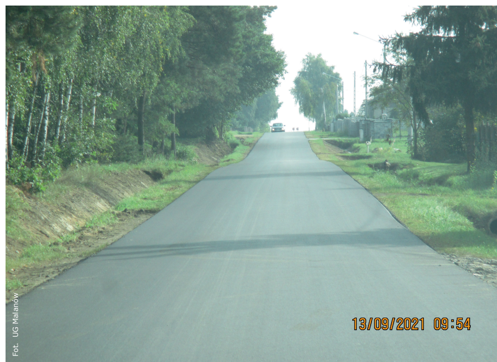
Wyremontowany odcinek drogi w Rachowej
