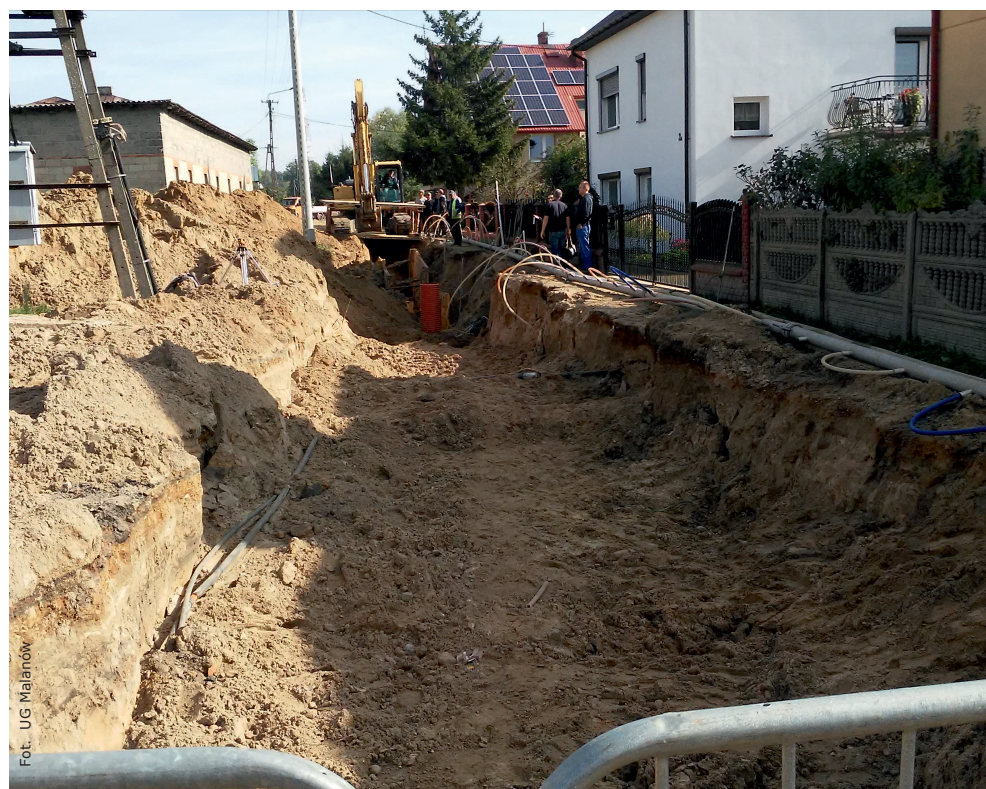
Budowa kanalizacji na ul. Stawiszyńskiej
