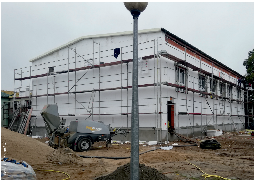
Nowopowstająca sala gimnastyczna przy szkole w Dziadowicach
